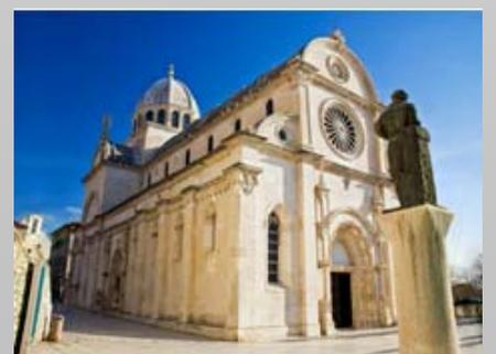
*Il y a dans cet édifice quelque chose de miraculeux : les blocs de la toiture et du dôme sont encastrés les uns dans les autres, sans le moindre gramme de mortier.*
